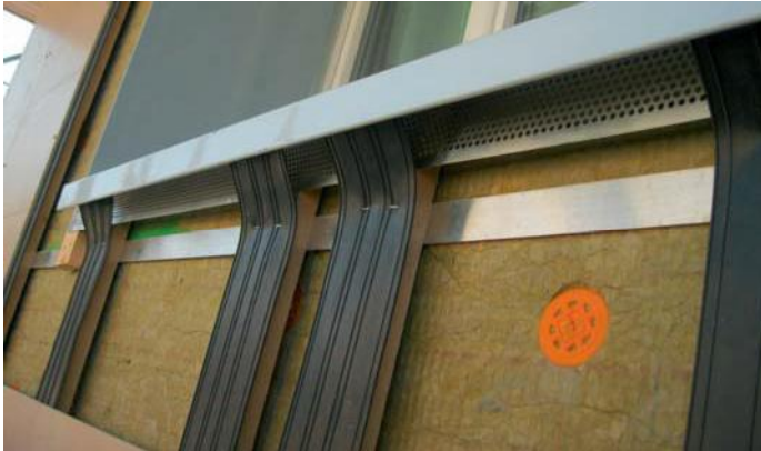
seitliche Leibungsdämmung
