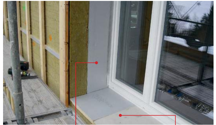
seitliche Leibungsdämmung
