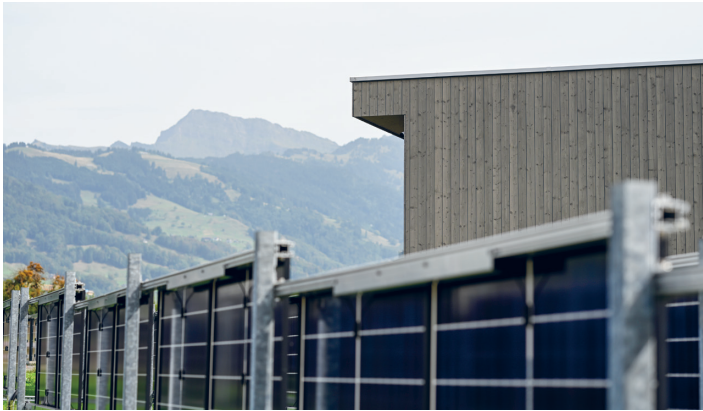
Abbildung 1: Im Holzbau am Rand der Parzelle befinden sich der Grossbatteriespeicher, inklusive Transformator und Mittelspannungsanschluss.
