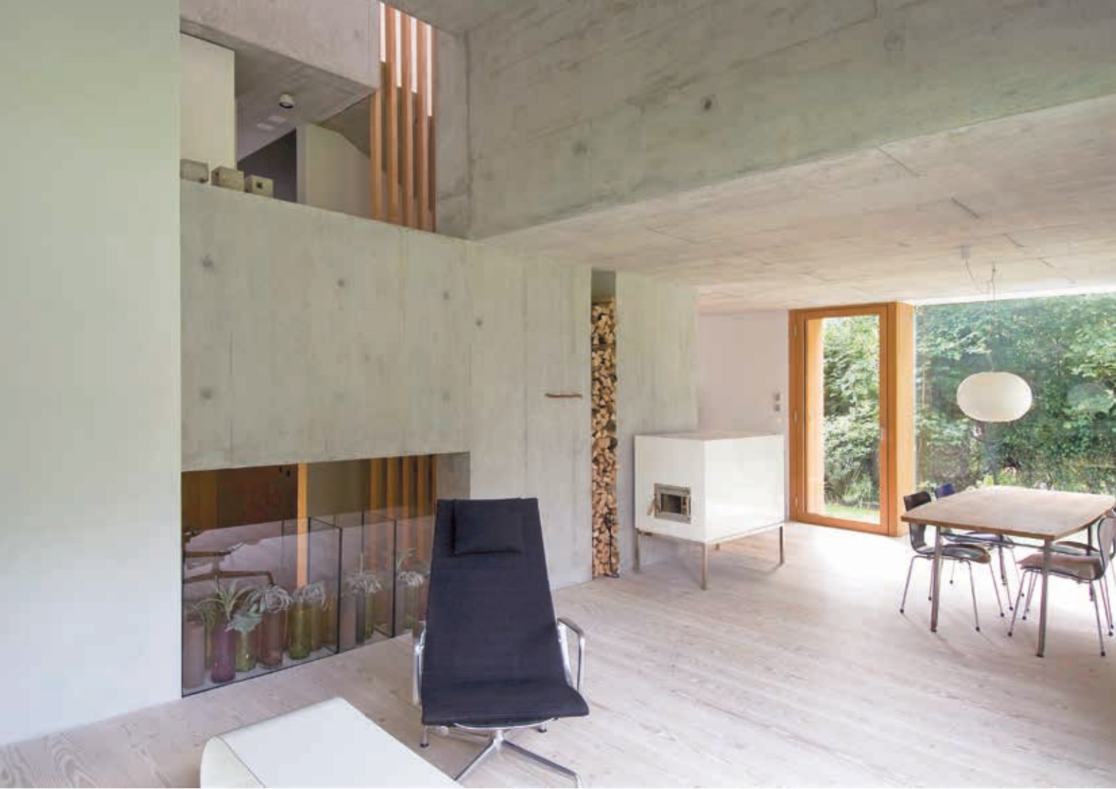
Ein Kleinspeicherofen im Wohnraum eines Einfamilienhauses.
